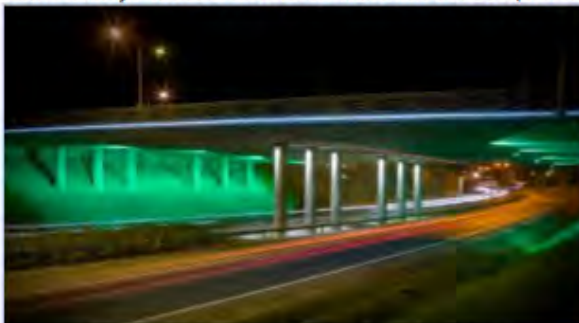
Lohikoskientien silta, Jyväskylä (yht. 42 000e)
