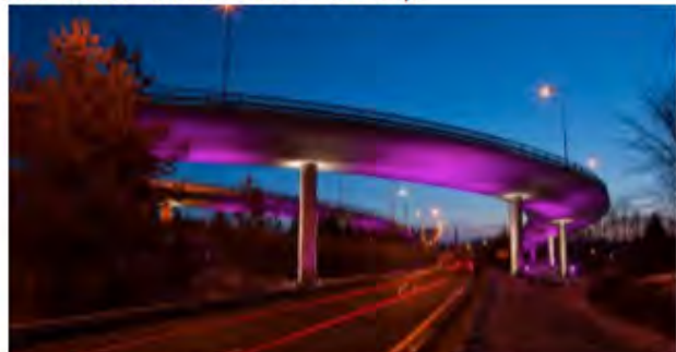
Vaasankadun silta, Jyväskylä (yht. 63 000e)
